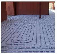
COP possible, il est souhaitable de réduire au maximum la température de la source chaude. Et donc idéalement de travailler avec des planchers chauffant.
