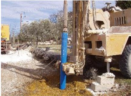
En pratique, la sonde est réalisée en forant un puits consolidé par un assemblage d'anneaux en ciment, dans lequel est introduite une épingle en U, le liquide (eau glycolée) descend dans le fond du puits et remonte réchauffé à 12°C. L'espace entre les parois du puits et la sonde est rempli de bentonite.
