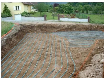
de la géothermie, tout en profitant aussi de l'inertie du sol. Le capteur doit être dimensionné selon le potentiel de prélèvement thermique du sol (entre 10 et 40 W/m<sup>2</sup> selon la VDI 4640) mais bien sûr aussi en fonction de la puissance nécessaire, donc de la surface à chauffer et du fluide circulant dans le capteur (fluide frigorigène ou eau glycolée). On considère dans les nouvelles constructions actuelles une surface moyenne de captage de l'ordre de 2 fois la surface à
